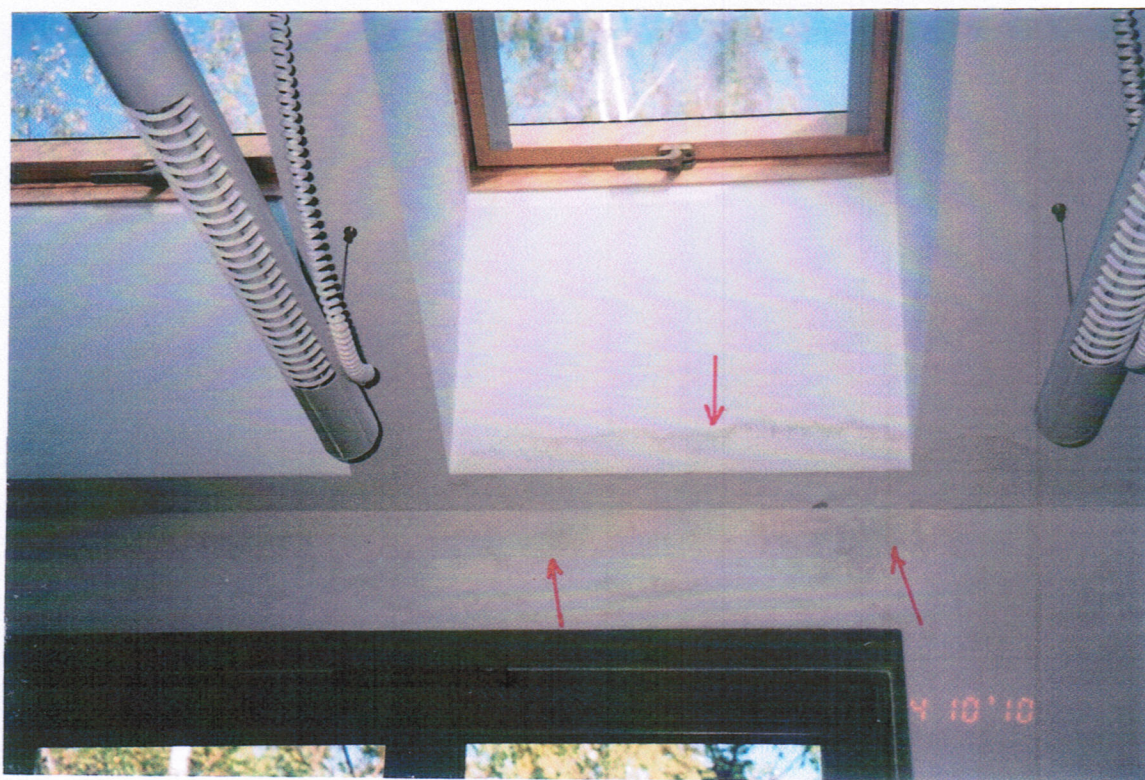
Rys.10z Jak rys.9z, zbliżenie zacieków
