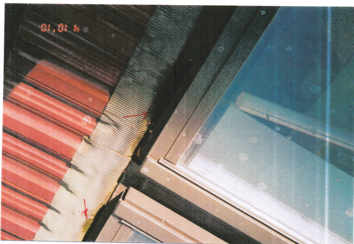
Rys.28z Podobnie jak na rys.27z, widoczne glony w miejscach gdzie były na fartuchu kałuże
