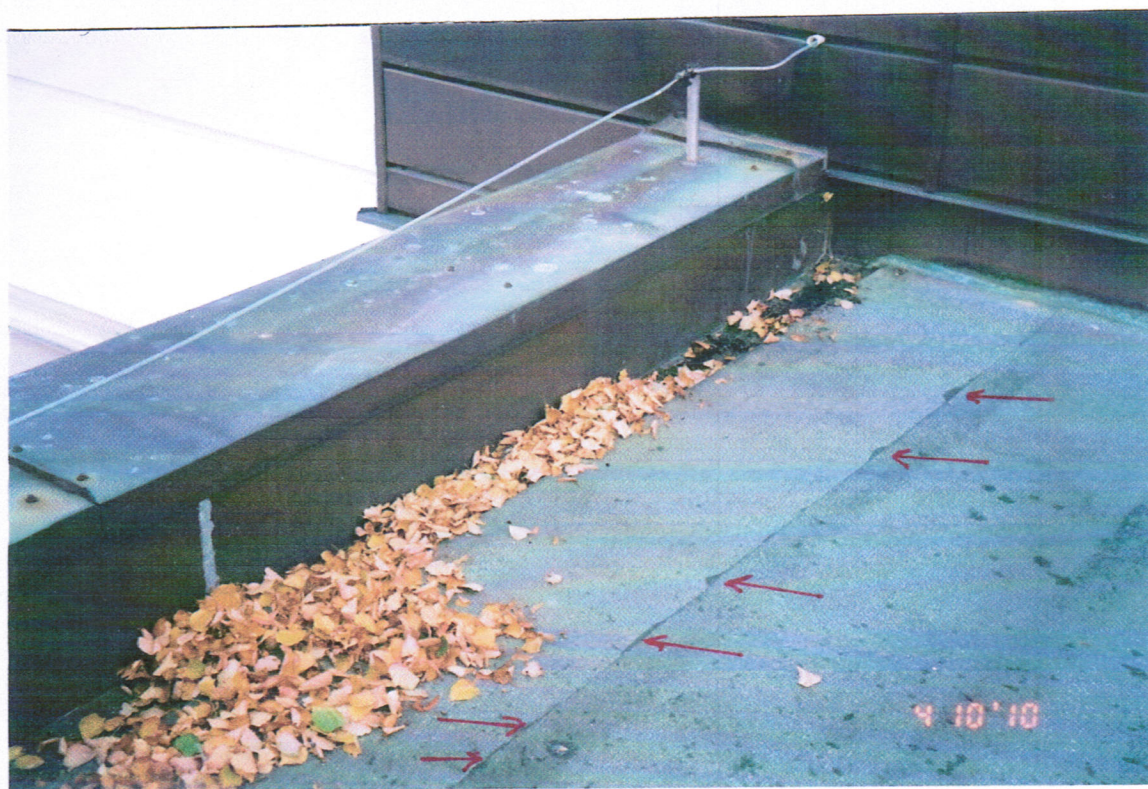
Rys.17z Połączenie prawej części dachu parterowego łącznika z nowym budynkiem przy ścianie pokoju nr 156, na stykach papy zgrzewalnej brak wymaganego ciągłego wypływu bitumu, przy ścianie budynku papa nie jest dokładnie przyklejona do poziomej obróbki blacharskiej (krawędzie papy nie są przyklejone)
