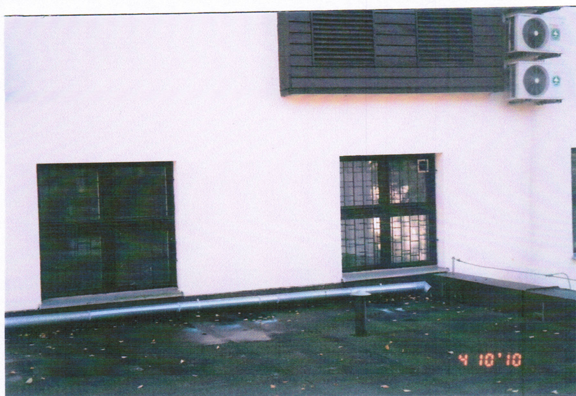
Rys.11z Widok z parterowego łącznika na ścianę starego budynku, wadliwe odprowadzenie wody z dachu starego budynku oraz wadliwa pozioma rura na dachu łącznika
