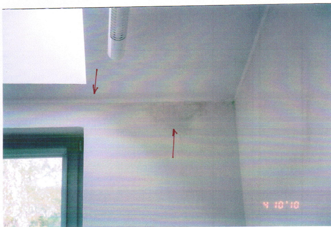
Rys.4z Jak rys.3z, zbliżenie zacieku
