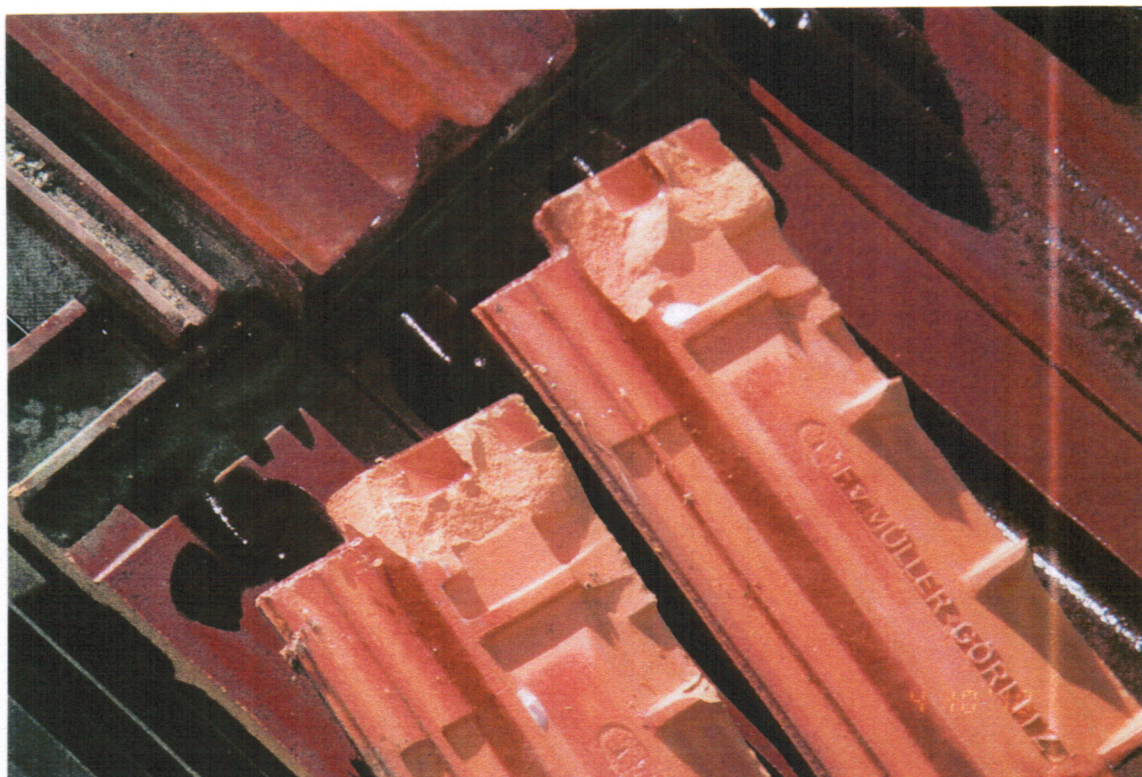
Rys.31z Dachówki przy podłużnych krawędziach nie były dodatkowo mocowane na wkręty jeżeli trzeba było przy nich ucinąć od spodu noski
