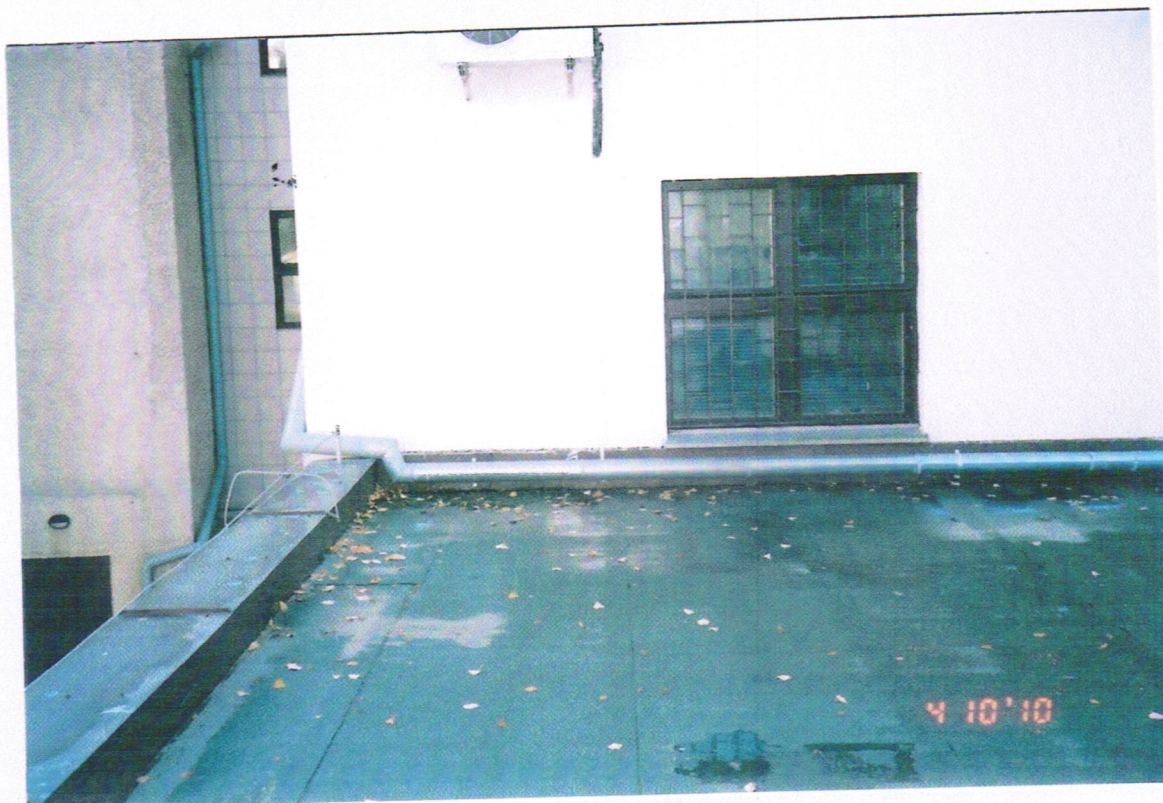
Rys.11z Widok z parterowego łącznika na ścianę starego budynku, wadliwe odprowadzenie wody z dachu starego budynku oraz wadliwa pozioma rura na dachu łącznika
