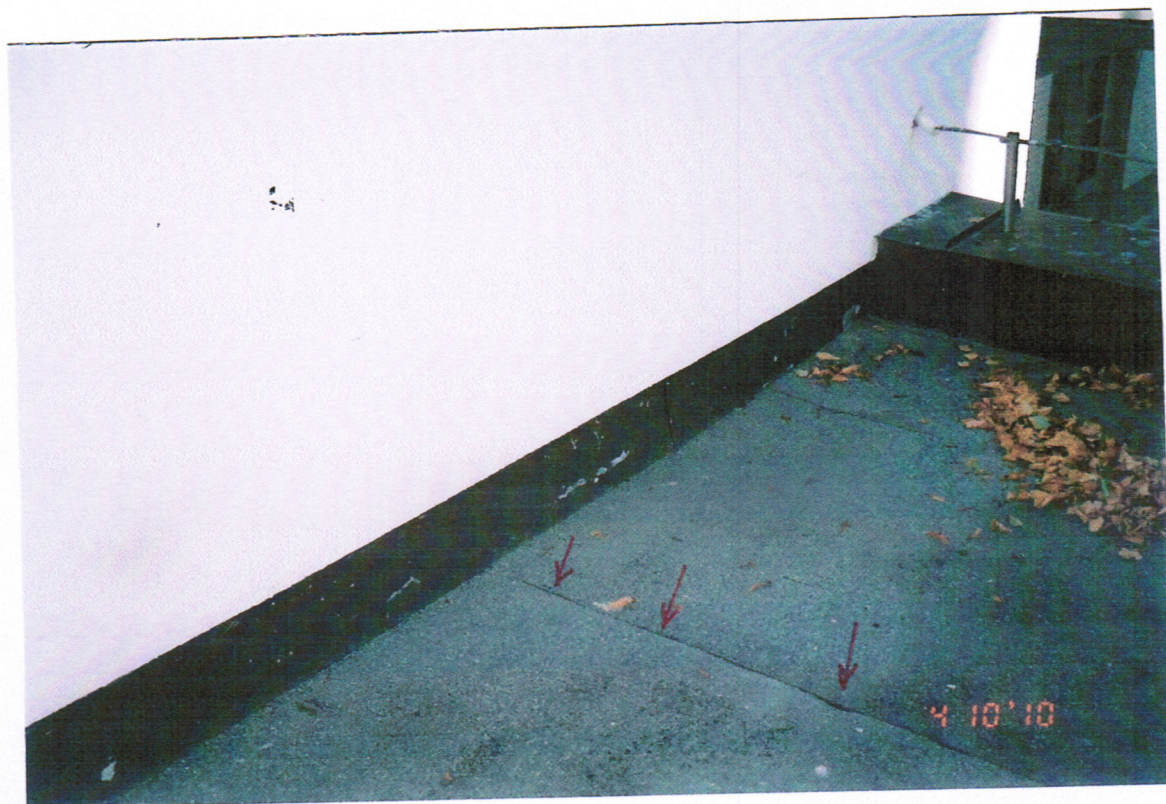
Rys.17z Połączenie prawej części dachu parterowego łącznika z nowym budynkiem przy ścianie pokoju nr 156, na stykach papy zgrzewalnej brak wymaganego ciągłego wypływu bitumu, przy ścianie budynku papa nie jest dokładnie przyklejona do poziomej obróbki blacharskiej (krawędzie papy nie są przyklejone)
