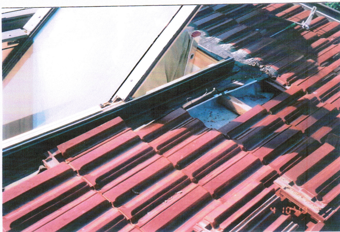
Rys.24z Jak rys.21z, odsłonięcie dachówek przy dolnej krawędzi okna
